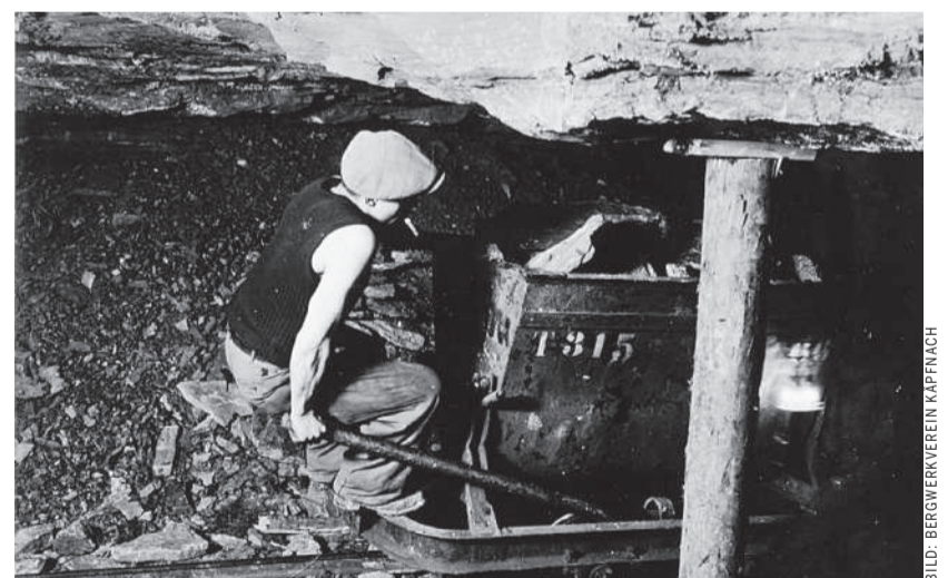
Kohleabbau im Stollen, ein Dokument aus dem Bergwerk Käpfnach bei Horgen
